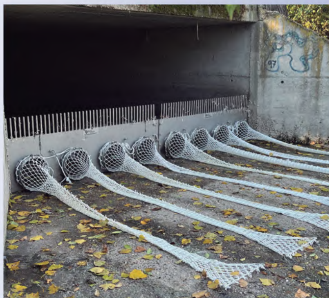
Deflecteur TecnoGrabber® en acier inoxydable, avec peigne supérieur.
