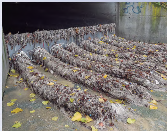
Deflecteur TecnoGrabber® en acier inoxydable, avec peigne supérieur.
