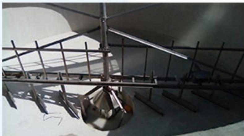
Au moyen d'un système de traction à axe central, ancré sur le pont, vous pouvez agir sur les pelles inférieures et agir ainsi sur la collecte de boue inférieure.
